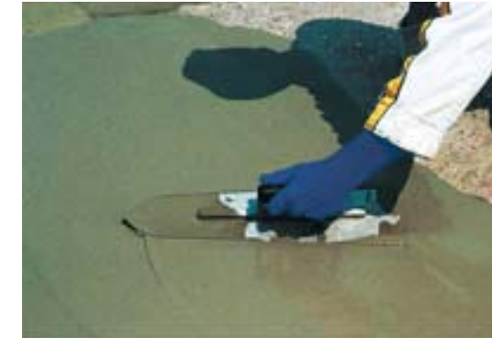
Application d'enduit autolissant.
