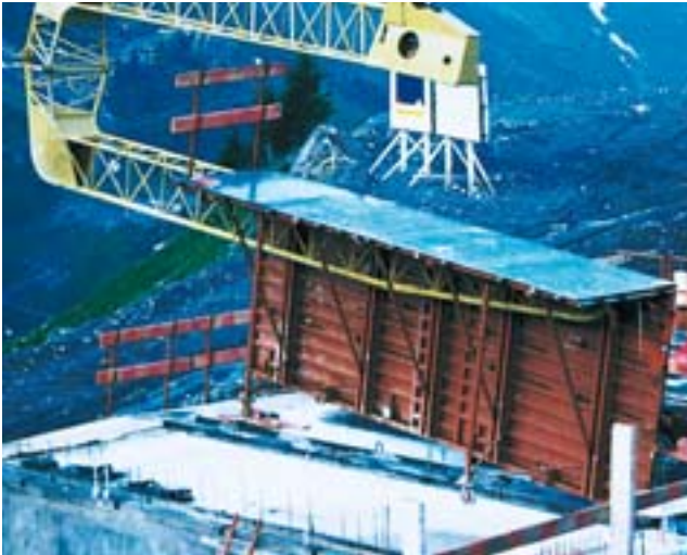
Coffrage tunnel demi-coquille.
