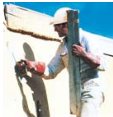
Serrage d'un enduit à la spatule.
