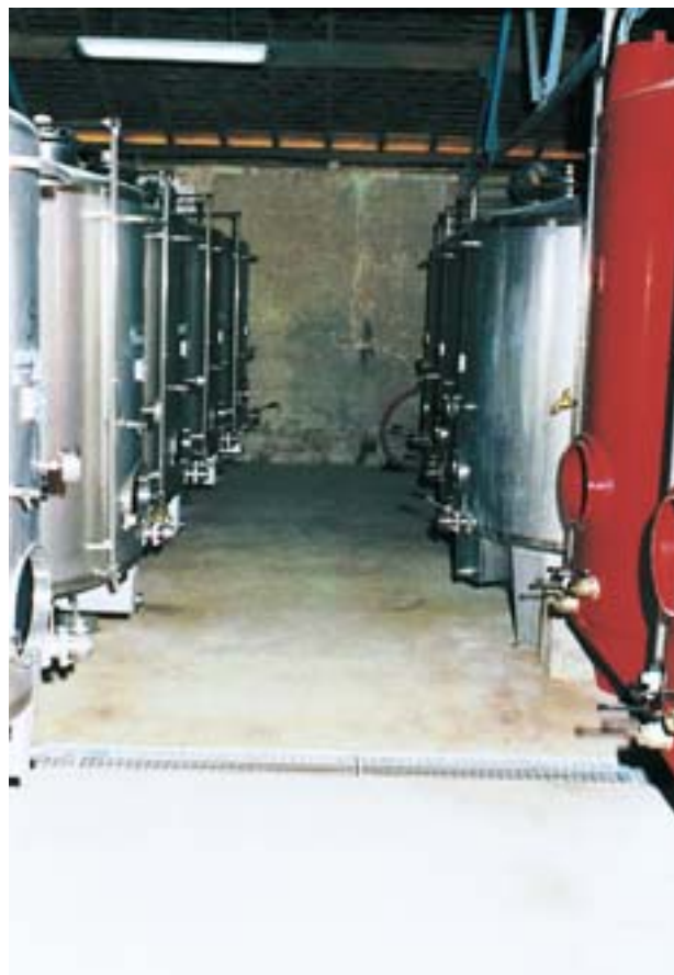
Une chape réalisée en mortier à base de ciment courant à caractéristiques complémentaires normalisées PM ES retenu pour sa résistance aux acides dans une laiterie.
