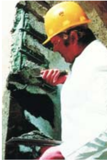
Une réparation nécessite différentes opérations : la passivation des armatures, la mise en place d'un mortier.
