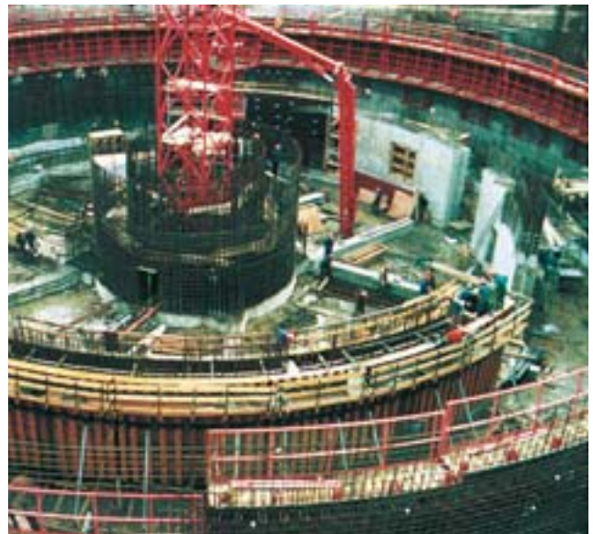
La complexité de certains ouvrages fait appel à des coffrages-ébénisterie, des coffrages métalliques structurés ou des coffrages de très grandes dimensions.
