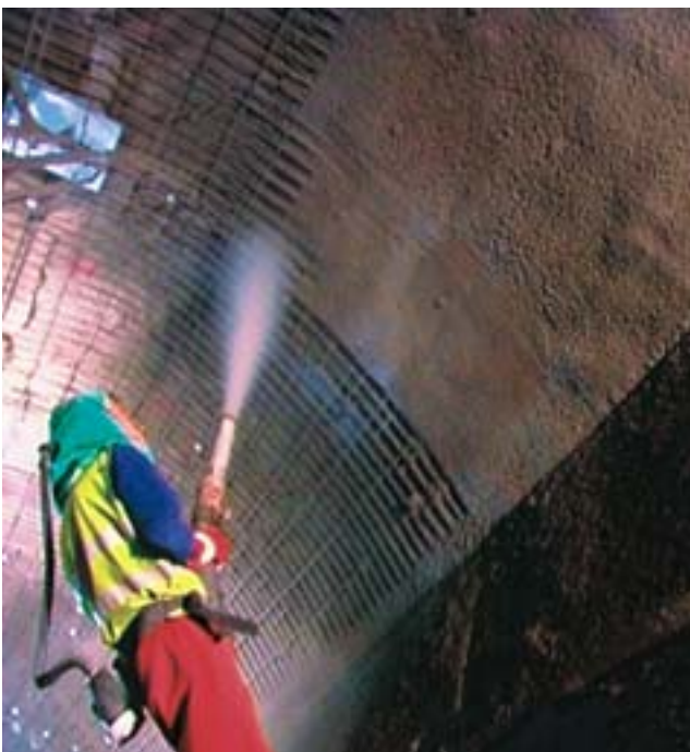
Réparation par projection : le mortier adhère fortement.
