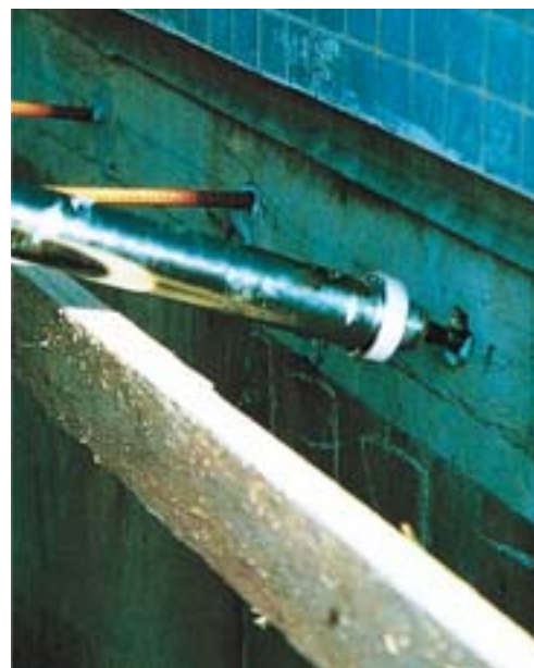
Injection d'un mortier de scellement.
