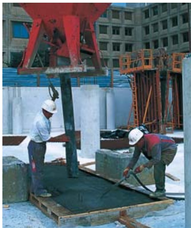
Sous l'effet de l'aiguille vibrante, l'air contenu dans le béton remonte à la surface.
