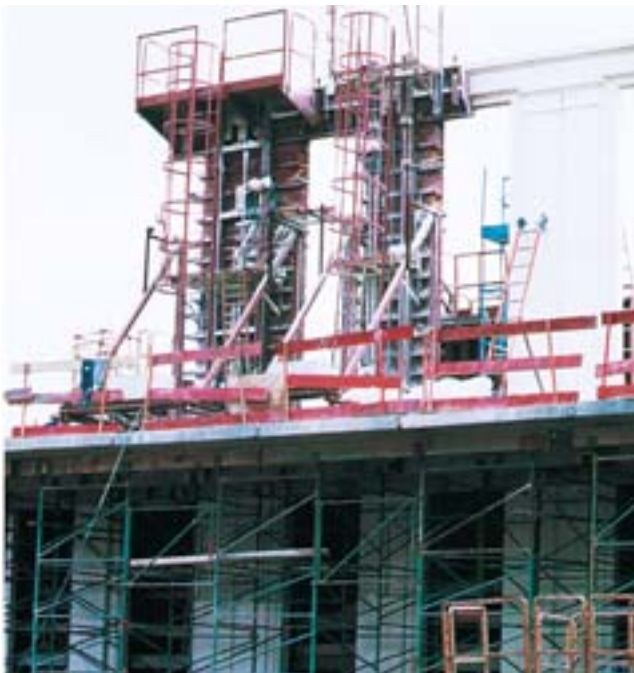
La complexité de certains ouvrages fait appel à des coffrages-ébénisterie, des coffrages métalliques structurés ou des coffrages de très grandes dimensions.
