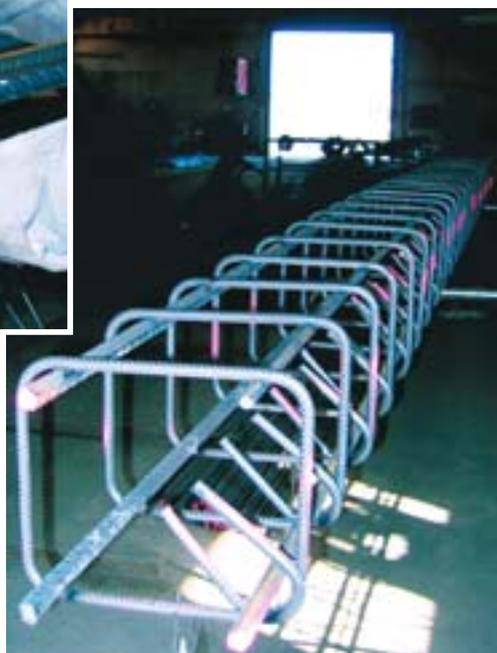
Sur chantier l'assemblage est effectué soit en atelier « forain » installé à proximité de l'ouvrage, soit directement en coffrage. En général ces deux solutions coexistent. L'entrepreneur assurant la pose choisit au cas par cas celle qu'il estime la plus pratique. Il est possible de souder sur site, mais le plus souvent, le montage se fait par ligatures avec des fils d'attache en acier recuit.
