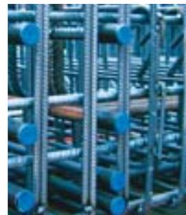
La fabrication des manchons eux-mêmes relève de l'industrie mécanique. Les procédés et la fabrication de ces manchons font l'objet d'une certification spécifique de l'AFCAB.
