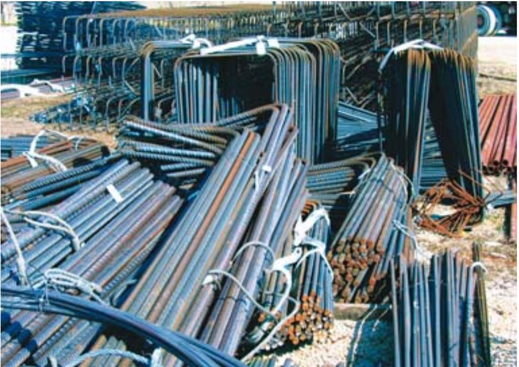
Parallèlement aux catégories qui viennent d'être décrites, on distingue aussi les « **armatures coupées-façonnées** » qui, comme leur nom l'indique sont obtenues par coupe et façonnage des aciers, et les « **armatures assemblées** » qui sont constituées par l'assemblage des armatures coupées-façonnées sous forme de « cages » ou de « panneaux ».
