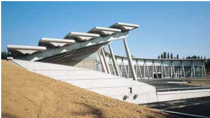
Centre d'entretien routier à Argenteuil.
