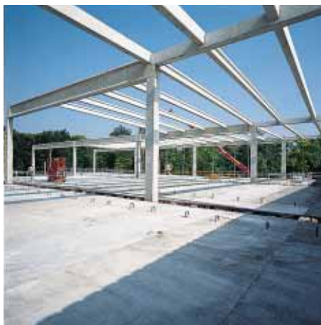
Centre de distribution Christian Dior à Saint-Jean-de-Braye.
