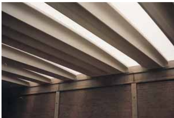
Couverture par coques en béton précontraint autoporteurs.
