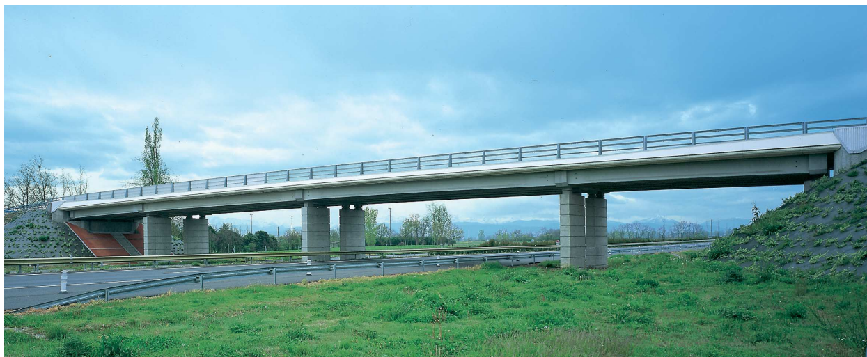
L'un des franchissements de l'A64 (reliant Muret à Saint-Gaudens) dessiné par les architectes Faup et Zirk.
