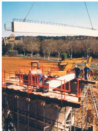
Mise en place des poutres.
