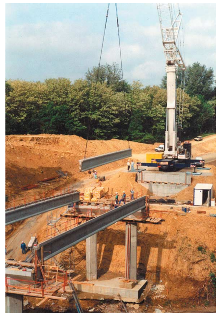
Mise en place des poutres.
