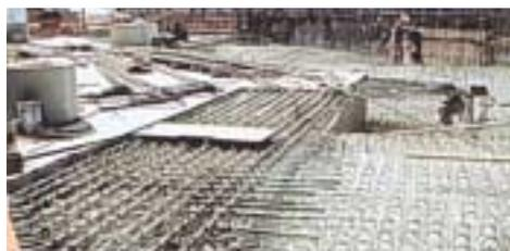
L'épaisseur de l'enrobage se calcule non pas à partir du nu de la paroi coulée, mais à partir des creux les plus profonds que les traitements ultérieurs ou les joints peuvent créer.
