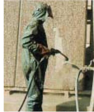
Traitement de finition par lavage au jet d'eau d'un béton préalablement désactivé.
