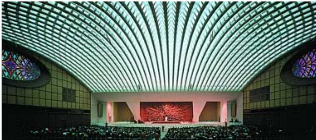
Pier Luigi Nervi, salle d'audience pontificale du Vatican. Voûte réalisée entièrement en éléments préfabriqués en béton.
