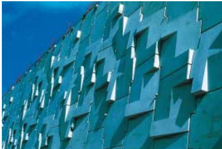
Autoroute A 40. Mur de soutènement en éléments préfabriqués en béton.
