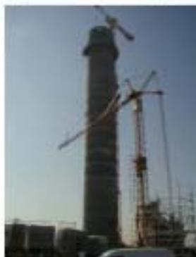
C'est la prise rapide du béton qui a permis le mouvement du coffrage, maintenu par un ferrailage connecté à la base de l'ouvrage : six heures après le coulage assuré par une grue, il est quasiment pris.
