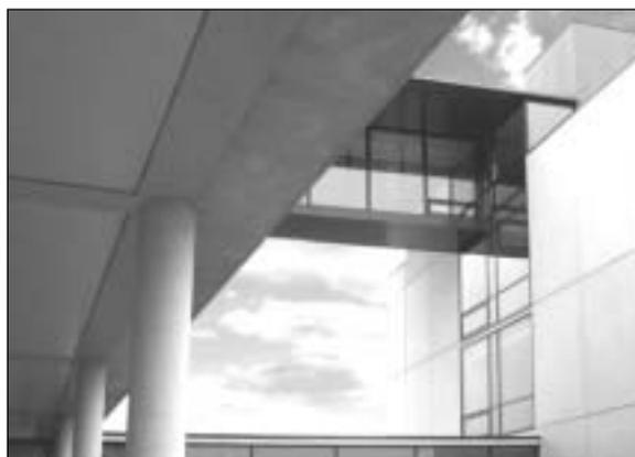
L'aile "recherche" est implantée à l'alignement sur la plus petite des rues. Elle présente un caractère plus domestique du fait de la taille plus réduite des salles qu'elle abrite. Elle est entièrement réalisée en panneaux préfabriqués de béton clair. De larges bandeaux saillants en béton encadrent les fenêtres horizontales sur rue. Un grand voile courbe vient terminer ce bâtiment et faire une sorte de proue en surplomb au-dessus du parvis d'entrée.
