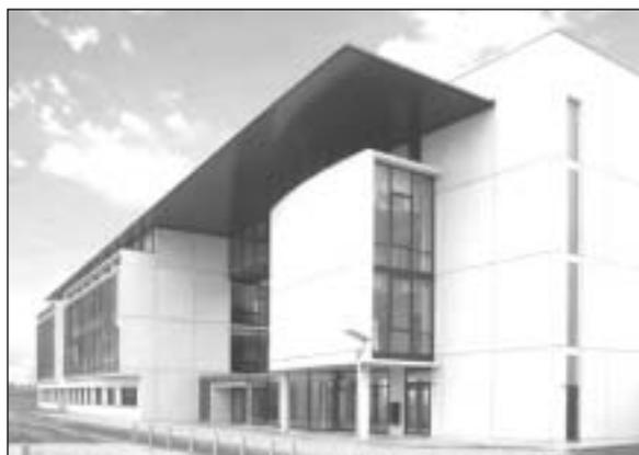
Il est composé de deux ailes de 4 niveaux, l'une abritant les locaux d'enseignements et l'autre les laboratoires de recherches ainsi que les bureaux des chercheurs. Ces deux entités sont reliées au rez-de-chaussée par un grand hall vitré et au troisième étage par une passerelle vitrée suspendue. Une grande toiture métallique débordante vient parachever la liaison et contribue ainsi à créer une porte urbaine qui ouvre visuellement la place centrale vers le Cher.
