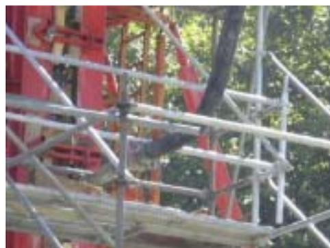
Injection du béton en pied de coffrage
